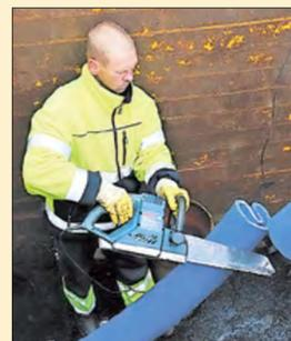
Mit der Säge fällt die Entscheidung über die benötigte Länge.
