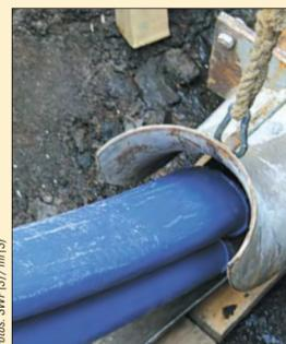
Eine simple Konstruktion erleichtert das Einbringen des PE-Rohrs.
