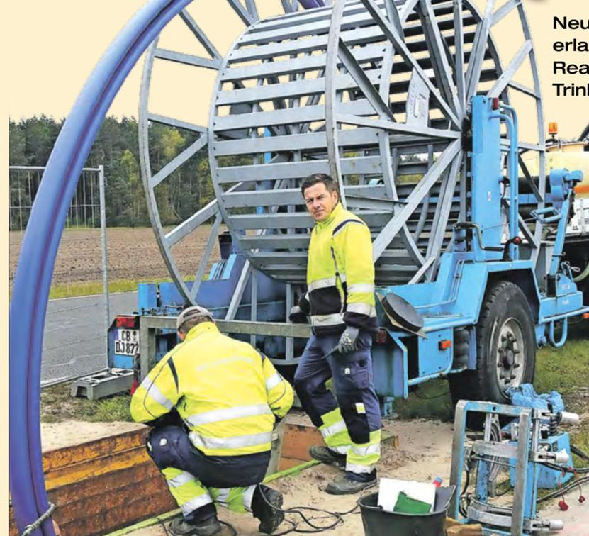
Vom „Riesenrad“ herab wird ein Rohrstrang mit noch eingestülptem Profil in die Startposition am alten Rohr gebracht.
